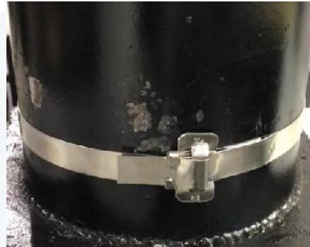
Fig. 6 Vista Posterior Fleje - Hebilla
