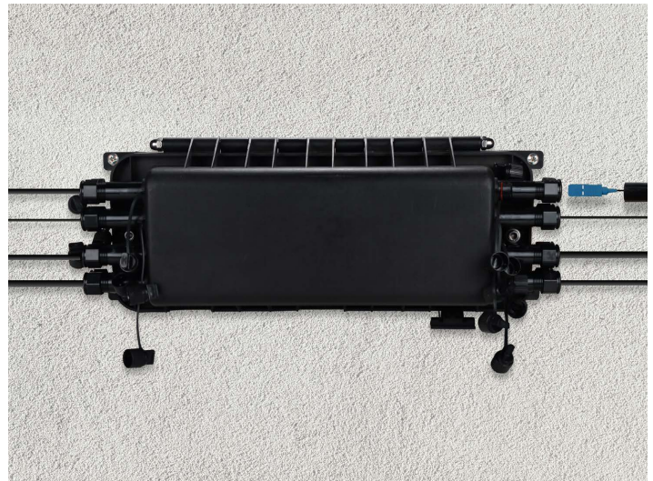
Montaje en muro
